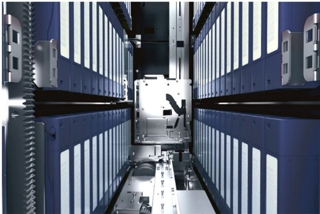
コールドストレージ内部
